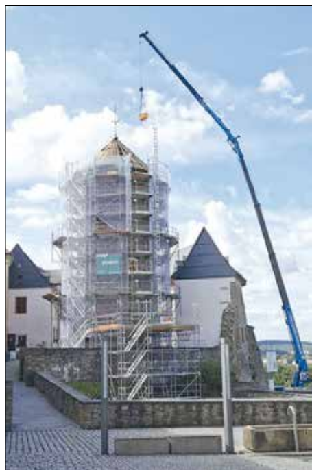
Mittels Kran wurde die Dachkonstruktion demontiert und die ehemaligen Wasserbehälter ausgebaut (Foto: Oelsnitzer Kultur GmbH)
