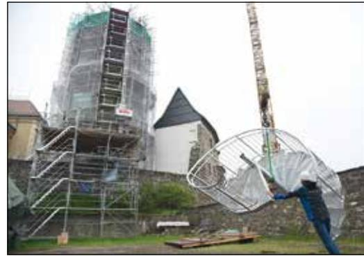
handenen, aber schadhaften Konstruktion und Verschieferung – wie es der Denkmalschutz zur Bedingung gemacht hatte – rekonstruiert.
