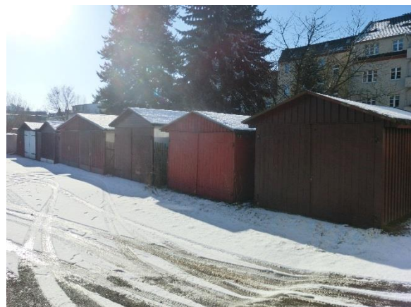
Frontansicht Garage 12 bis 19
