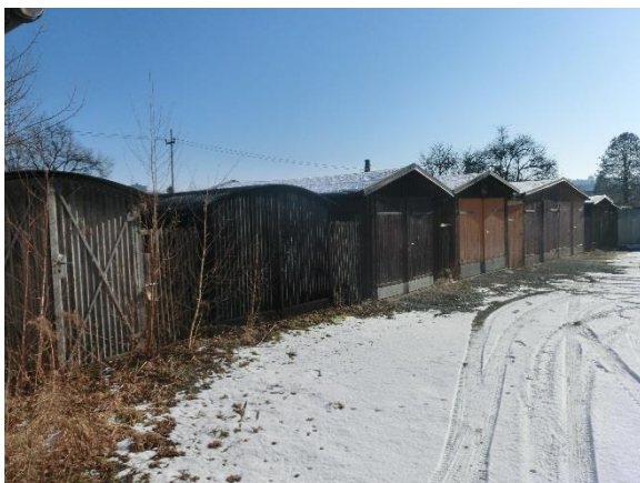
Frontansicht Garage 4 bis 11
