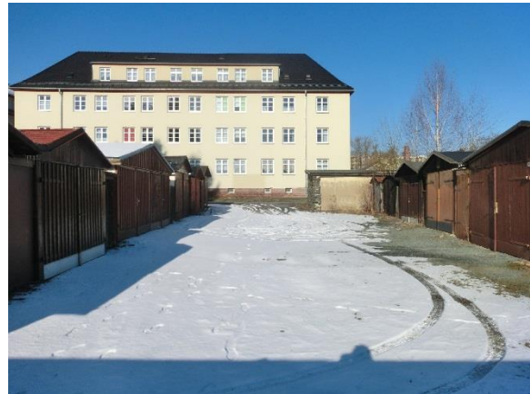
Blick aus südöstlicher Richtung
