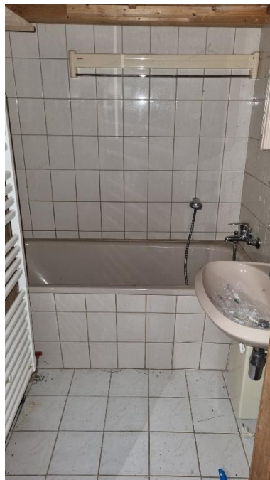
Bad EG Wohnhaus
