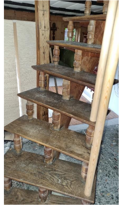
Treppe zum DG Wohnhaus
